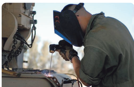
被覆アーク溶接作業
