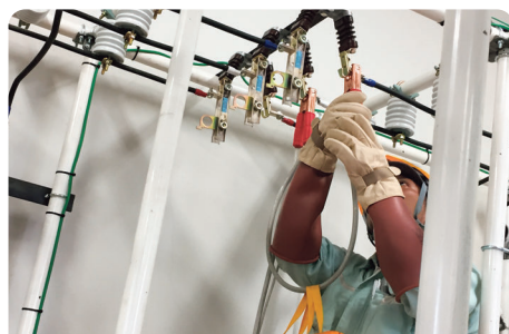
高圧設備工事
