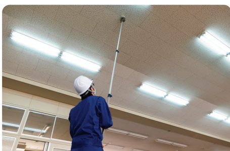
消防設備工事
