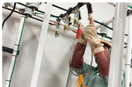
高圧設備工事
