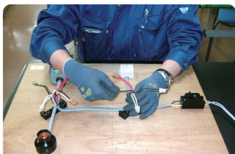
電気配線工事作業
