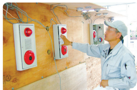
消防設備保全作業
