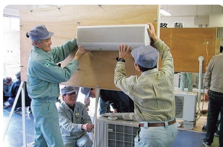
空調設備管理作業
