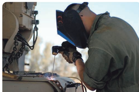
被覆アーク溶接作業
