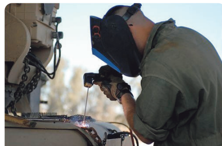
被覆アーク溶接作業
