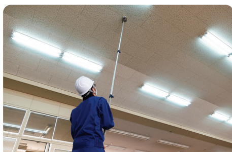
消防設備工事
