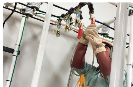
高圧設備工事
