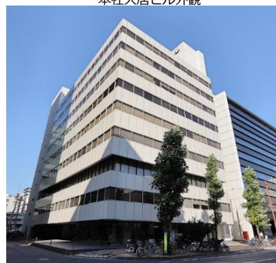
株式会社百十四システムサービス 本社入居ビル外観
