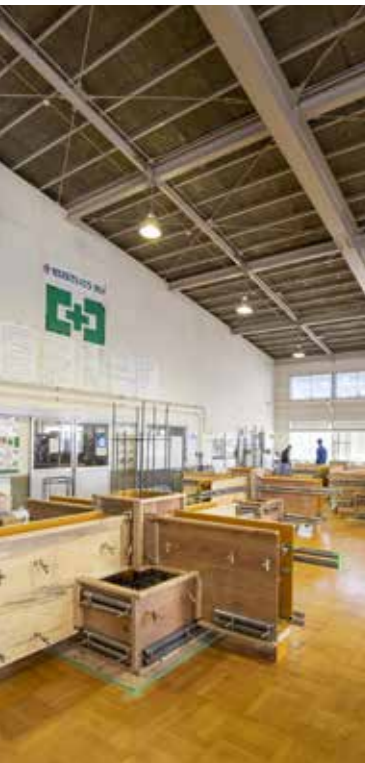
配筋技能検定2級の課題に型枠を施工する実習
