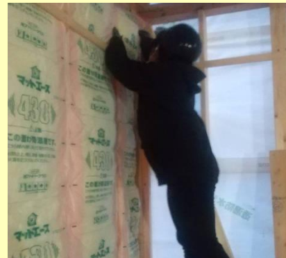
断熱材施工（訓練で行ったことが活かしています）
