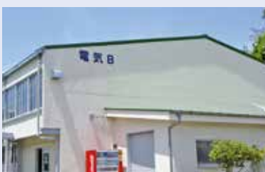
⑤ 電気B実習場 (電気設備技術科【短期デュアルコース】)
