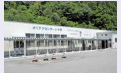
① 本館 (多目的ホール)
