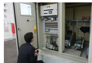
写真-1 制御盤等現場調査
