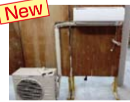
空調設備工事
