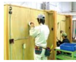
一般用電気設備工事I
