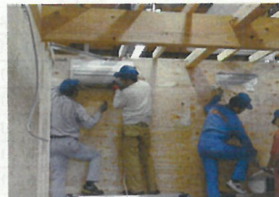
新たに取り入れる「空調設備工事・太陽光システム工事」の訓練
