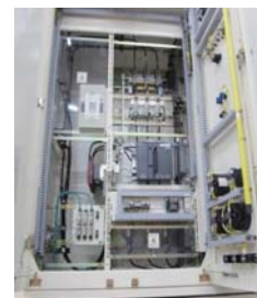
[キュービクル形受変電設備]
