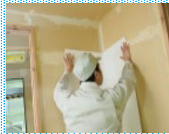
木造住宅の内装 施工と仕上げ
