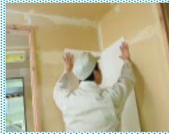
木造住宅の内装 施工と仕上げ
