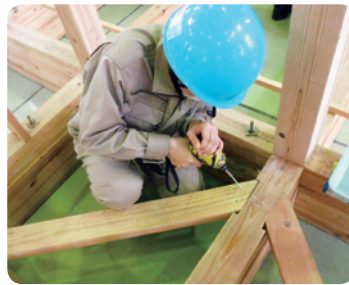
躯体施工作業
