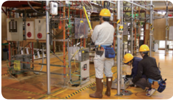
高圧受電設備保守作業
