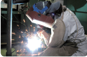
炭酸ガスアーク溶接作業
