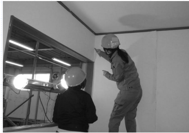
内装施工(クロス)
