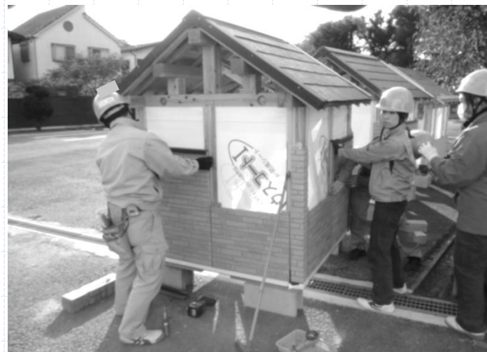
外装施工(外壁)
