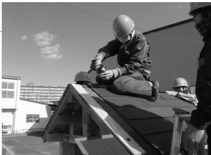
外装施工(屋根)
