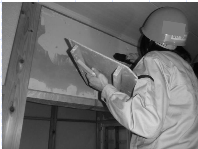
内装施工(下地)
