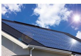
ソーラー電池をたくさん集めてパネル状にしたものを作ります。ソーラーパネルを日当たりのいい場所(屋根や屋上)に設置し、発電した電気を蓄電池にためて、使用できるようにしたものを「太陽光システム」という。目前で発電した電気を利用できることから、商用電力の使用を減らすことができます。また、化石燃料や原子力による発電にかわる、再生可能エネルギーとして注目されています。一般家庭やビル、工場で使用する電気は交流といわれる電気を使用しますが、ソーラーパネルで発電する電気は直流です。直流の電気を直接利用することはできないためパワー・コンディショナー(略して「パワコン」といいます)といわれる電力変換器を使って交流の電気に変換します。
