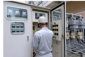
高圧受変電設備は、工場や学校、病院、商業施設など多くの電気を使う場所に設置されている設備です。電気には、より高い電圧で送電した方が送電によるロスが少なくなるという性質があります。そのため、大きなビルや商業施設、工場のような多くの電力が必要になる場所では、6,600Vという高い電圧の電気を直接受けるようになっています。そのような高圧の電気を受けるために必要なのが高圧受変電設備です。高圧受変電設備では、発電所から送られてきた高い電圧の電気を施設内の設備(照明器具など)で使用できる電圧(100V/200V)に変換します。また、配電線から雷が侵入するのを防止したり、漏電等が起こった際に、事故が波及しないよう遮断することができます。
