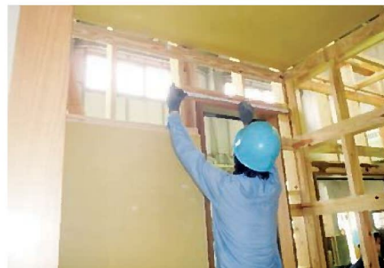
<内装下地施工>
