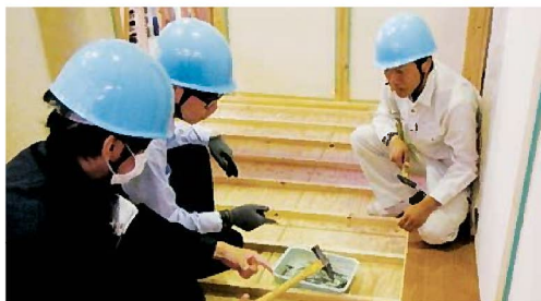
リフォーム工事 (床の貼替え)
