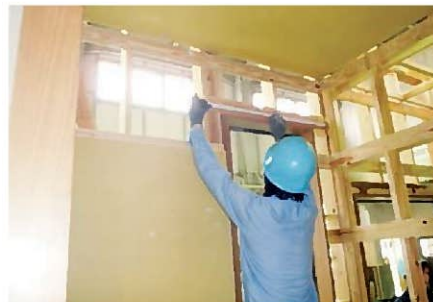
<内装下地施工>
