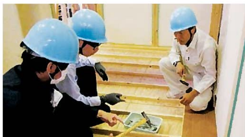
リフォーム工事(床の貼替え)
