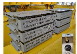
図13 二次抵抗制御装置
