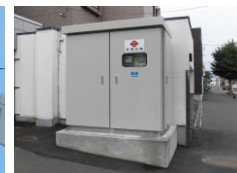
●キュービクル新設・入替工事
