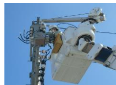
●PAS更新工事
