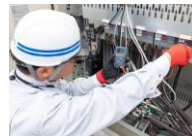
●高圧受電盤工事
