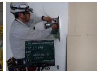
●公共施設の弱电設備施工
