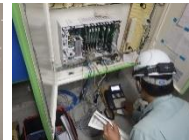
●設備施工後の試験確認
