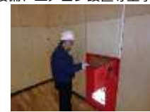
●消防設備工事
