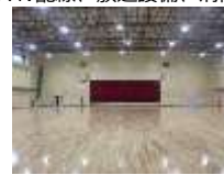
●照明取付工事
