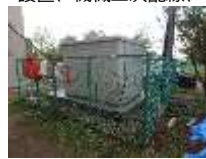
●受変電設備設置工事
