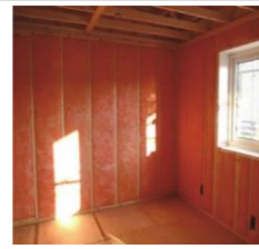
断熱材の施工例
