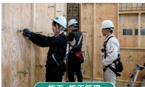
施工・施工管理
