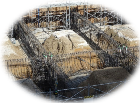
土工事・基礎部の躯体
