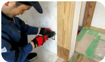
電気工事の仕事
