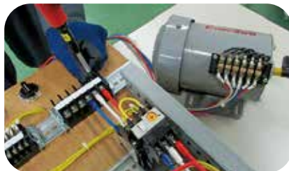
制御盤を製作する仕事
