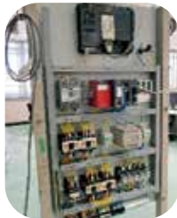
制御盤を製作する仕事
