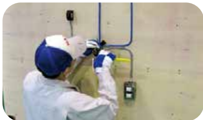
電気工事をする仕事
