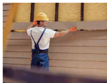
内装模様替／外装仕上げ
