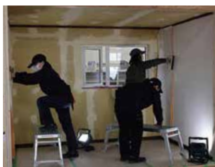
内装施工・改修
