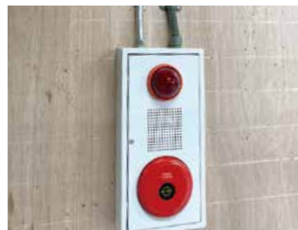
防災設備工事
