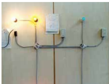
一般用電気設備工事
