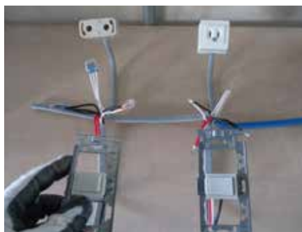
電気配線工事
