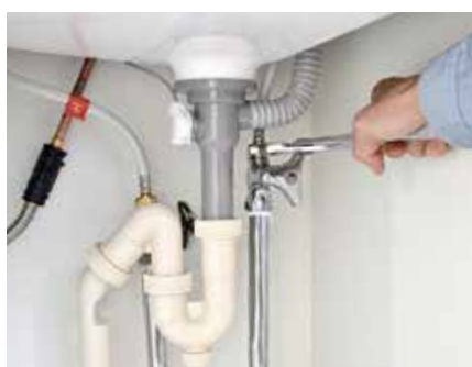
給排水衛生設備保全作業
