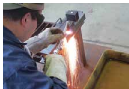
鉄鋼製作作業
