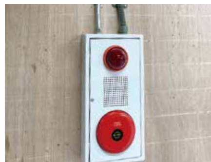
防災設備工事
