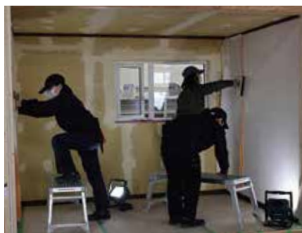
内装施工・改修
