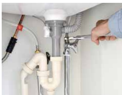
給排水衛生設備保全作業
