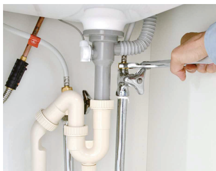
給排水衛生設備保全作業
