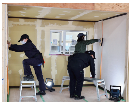
内装施工・改修
