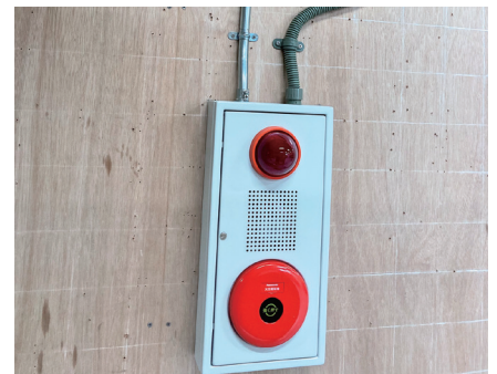
防災設備工事
