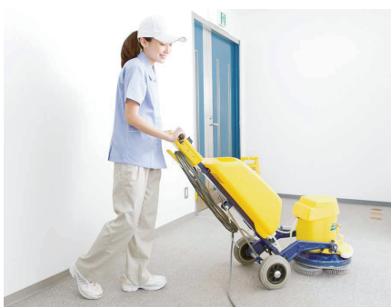
冷媒配管作業・ビルクリーニング作業
