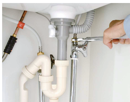
給排水衛生設備保全作業
