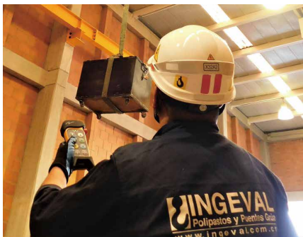
被覆アーク溶接・構造物運搬
