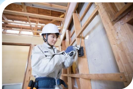
【電工テクノ科 (施工コース)】
