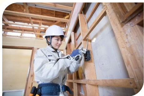
【電工テクノ科(施工コース)】
