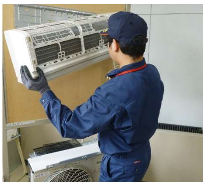
エアコン工事
