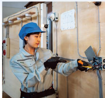
電気配線試験
