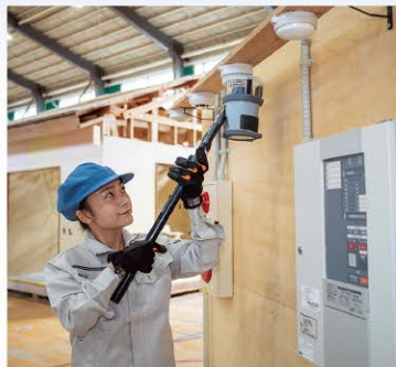
自動火災報知設備点検作業
