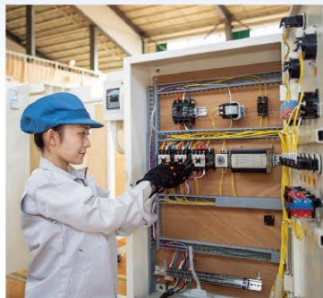
シーケンス制御配線作業
