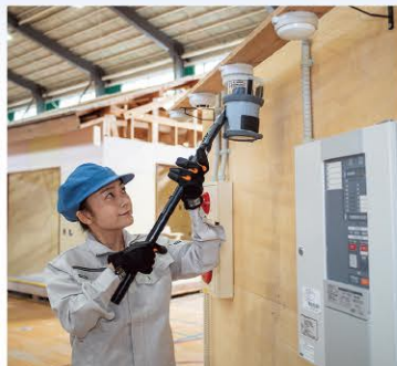
自動火災報知設備点検作業
