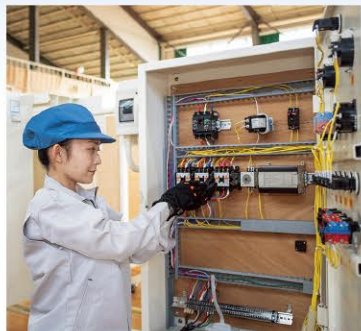
シーケンス制御配線作業
