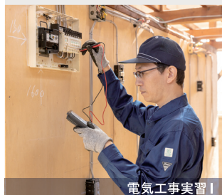
電気工事実習Ⅰ
