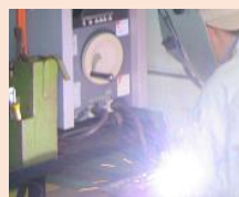
被覆アーク溶接
